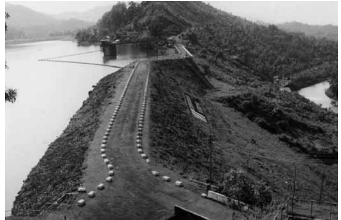
Foto: Bendungan Sempor di Kabupaten Kebumen, Jawa Tengah, setelah selesai dibangun pada tahun 1978 (foto koleksi Puslitbang Sumber Daya Air, 2004)
